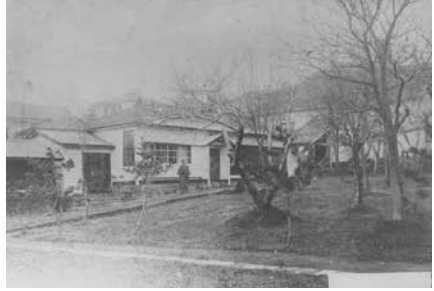
37 正教女学校（境内の南東の角にあった）
