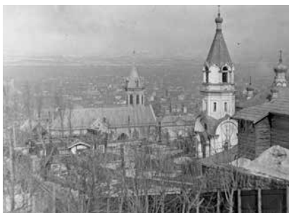
65 暴風で屋根が大破した司祭館
